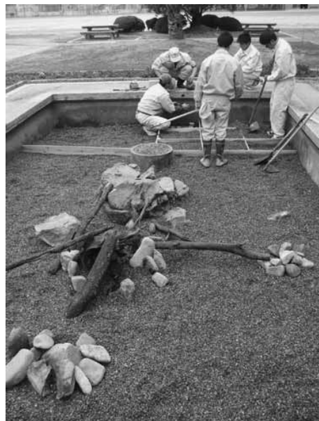
写真 ビオトープの改修工事
